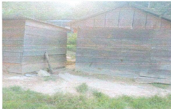
Foto 2: Mejoramiento de paredes a muros de block de la EORM Caserío Concepción las Flores
